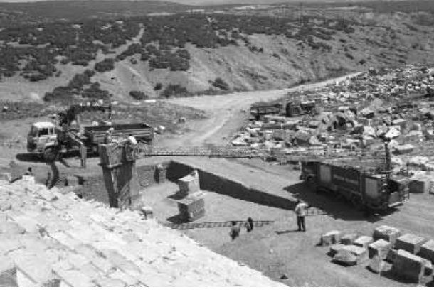
Res. 3 Propylaion, konservasyon çalışmaları Fig. 3 Propylaion, conservation work
